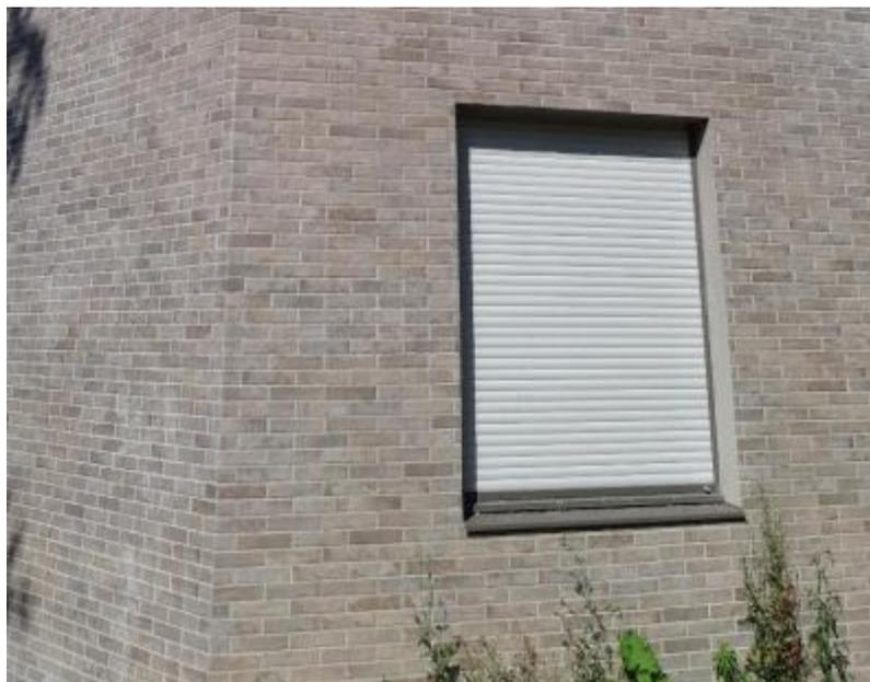
**Photo 2 - Installation des formats 6x25 cm avec joints décalés 1/2**
