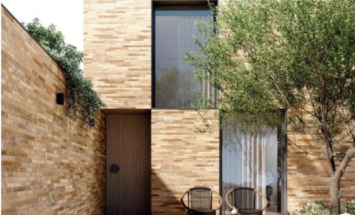
**Photo 1 - Installation des formats 4.8x45 cm avec joints décalés 1/3 - 2/3**
